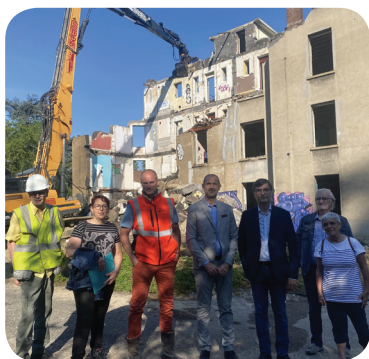
Lancement de la démolition de la résidence Leclerc I à Vienne JUIN
